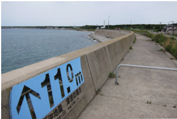
奥尻島富里地区に築かれた 11 メートルの防潮堤
